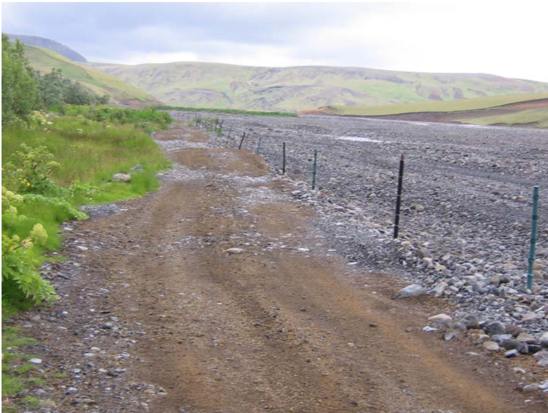
Séð til austurs. Vegarstæðið eins og það var. Sjá má hvernig ofaníbúður skolast úr veginum eftir rigningar.
