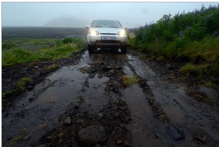
Gilbraut. Staðan er slæm neðan til. Gróft efni, mól og mold. Lækur rennur eftir veginum í vætutið. Getur ekki með góðu móti talist fólksbilafær. Þetta er í talsverðum bratta.
